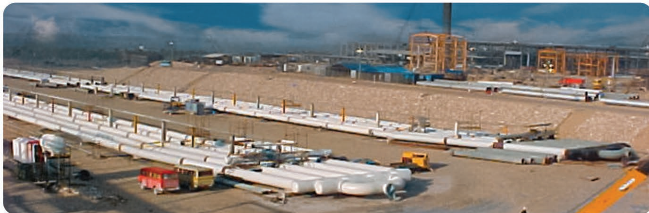
اسلگ کچر (لخته گیر) فازهای ۴ و ۵ پارس جنوبی اجرای لوله کشی با لوله سایز ۴۶" و ضخامت حدود ۵ سانتی متر و نصب و اجرای لوله کشی خطوط ۱۰"
