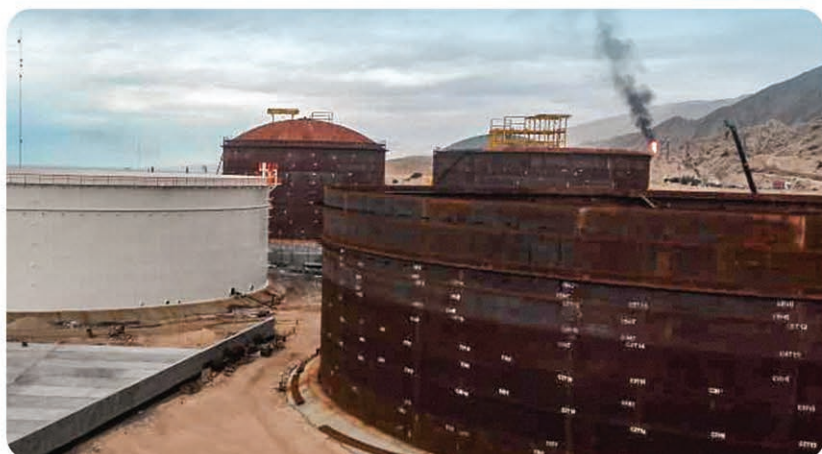
پروژه احداث دو دستگاه مخزن ذخیره C5+ بصورت EPC در بندر عسلویه انجام خدمات مهندسی، تأمین اقلام مصالح و تجهیزات، ساخت و نصب توأم دو دستگاه مخزن ذخیره C5+ به ظرفیت ۷۰,۰۰۰ m ۳ محصول
