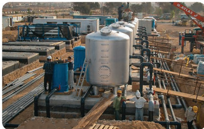
طراحی، خرید، ساخت آب شیرین کن فازهای ۶، ۷ و ۸ پارس جنوبی اجرا و نصب آب شیرین کن با ظرفیت ۱۱,۰۰۰ مترمکعب در روز
