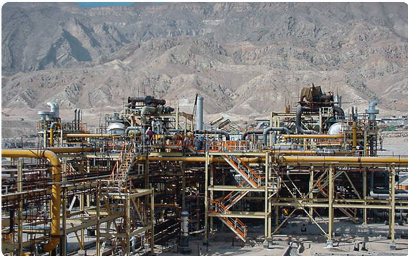
لوله کشی و مکانیکال واحد سولفور فاز یک عسلویه اجرای ۸۰,۰۰۰ اینچ لوله کشی با سایزهای مختلف از مرحله فیت آپ تا پیش راه اندازی
