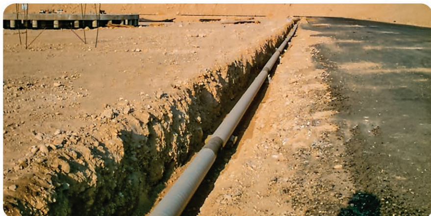
لوله کشی زیر زمینی پتروشیمی اوره و آمونیاک ۱ اجرای لوله کشی ۳۰۰۰ اینچ بر قطر، لوله کشی زیر زمینی از سایز ۲" تا ۸۰"
