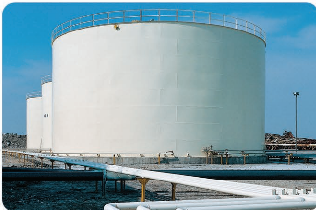
تهیه کالا، طراحی، خرید، ساخت پایانه صادرات نفتی ساخت یک مخزن ۵۰۰۰ مترمکعبی سقف شناور و دو دستگاه مخزن ۳۰۰۰ مترمکعبی و اجرای تاسیسات مربوطه
