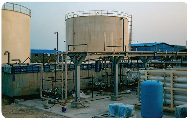
آب شیرین کن فازهای ۴ و ۵ پارس جنوبی اجرا و نصب آب شیرین کن با ظرفیت ۵۴۰۰ مترمکعب در روز
