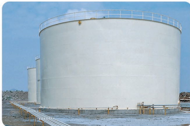
تهیه کالا، طراحی، خرید، ساخت پایانه صادرات نفتی ساخت یک مخزن ۵۰۰۰ مترمکعبی سقف شناور و دو دستگاه مخزن ۳۰۰۰ مترمکعبی و اجرای تاسیسات مربوطه
