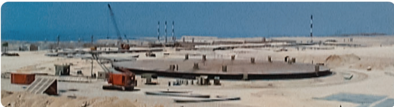
پروژه احداث ذخیره نفت تأسیسات آتش نشانی و مخازن مایع گیر در واحد بهره برداری قشم بصورت EPC انجام خدمات طراحی و مهندسی، تأمین مصالح و تجهیزات، اجرای کارهای ساختمانی و نصب و راه اندازی برای ذخیره نفت تأسیسات آتش نشانی و مخازن مایع گیر در واحد بهره برداری قشم واقع در جزیره قشم - خلیج فارس
