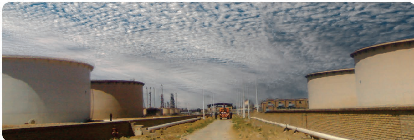
پروژه احداث مخزن ذخیره سوخت گازوئیل نیروگاه سیکل ترکیبی فارس بروش EPC بررسی طرح، تهیه و تأمین کلیه مصالح و تجهیزات، انجام کلیه عملیات ساختمانی، ساخت و نصب و راه اندازی یک دستگاه مخزن 3,000 \text{ m}^3 سوخت گازوئیل
