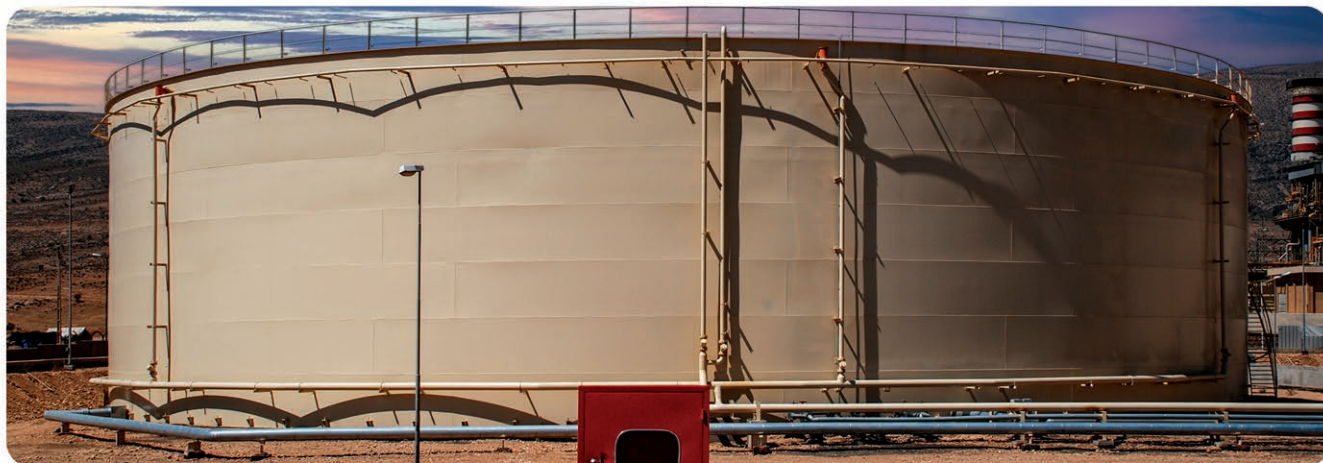
پروژه احداث مخزن ذخیره سوخت گازوئیل نیروگاه سیکل ترکیبی فارس بروش EPC بررسی طرح، تهیه و تأمین کلیه مصالح و تجهیزات، انجام کلیه عملیات ساختمانی، ساخت و نصب و راه اندازی یک دستگاه مخزن 3,000 \text{ m}^3 سوخت گازوئیل
