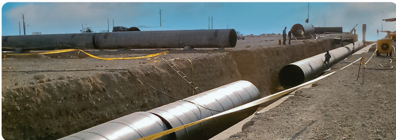
لوله کشی زیر زمینی پتروشیمی اوره و آمونیاک ۲ اجرای لوله کشی ۲۵۰۰۰ اینچ بر قطر، لوله کشی زیر زمینی از سایز ۲" تا ۸۰"
