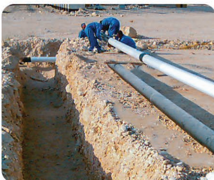
لوله کشی زیر زمینی پتروشیمی اوره و آمونیاک ۲ اجرای لوله کشی ۲۵۰۰۰ اینچ بر قطر، لوله کشی زیر زمینی از سایز ۲" تا ۸۰"
