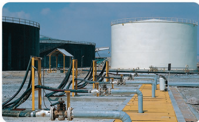
لوله کشی و مکانیکال واحد سولفور فاز یک عسلویه اجرای ۸۰,۰۰۰ اینچ لوله کشی با سایزهای مختلف از مرحله فیت آپ تا پیش راه اندازی
